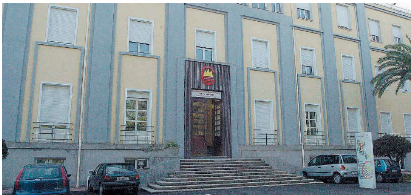
Ciacchio-De Lellis. Il plesso sarà oggetto di ampliamento e ospiterà l'Oncologia
